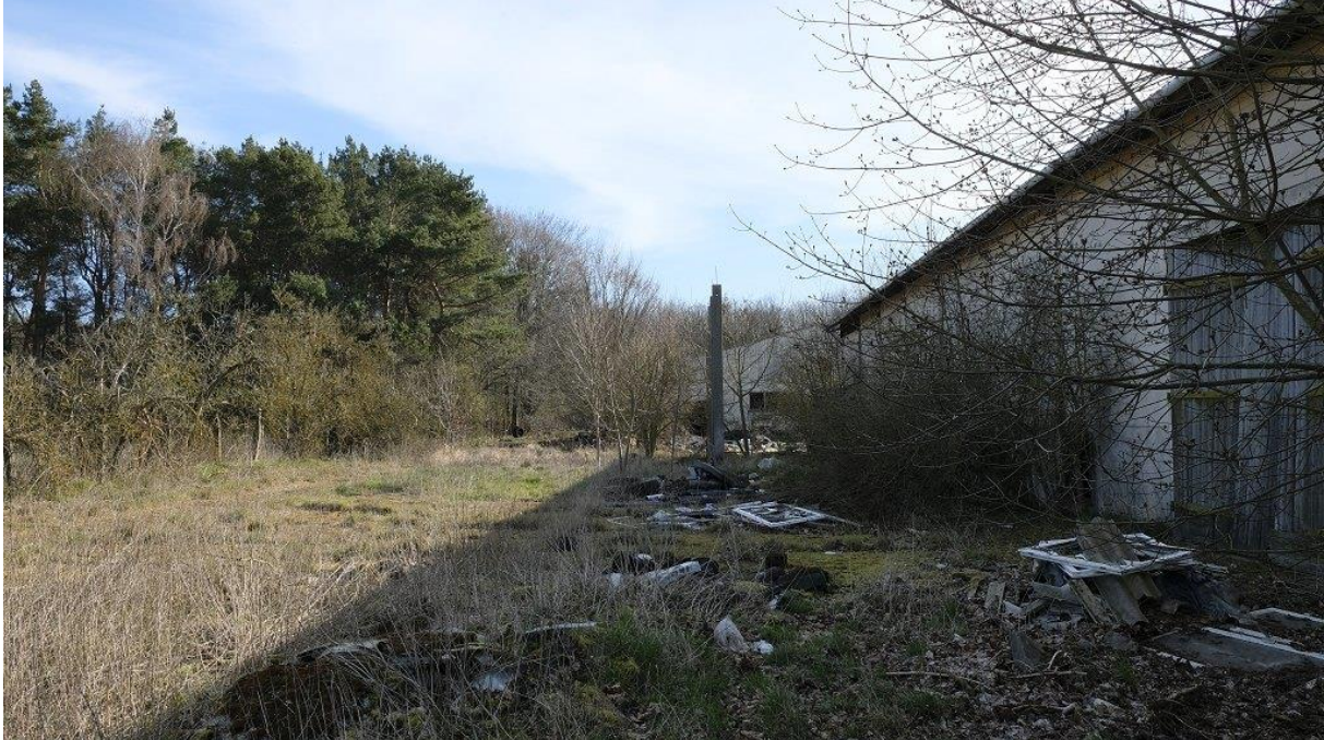
Abbildung 12 Rechts Gebäude 6 links im der Kieferforst nördlich des B-Plans
