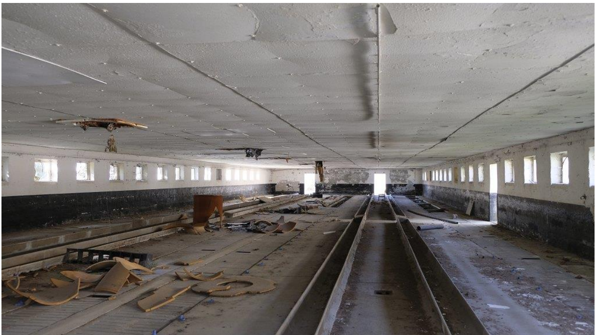
Abbildung 17 Blick in das Gebäude Nr.8
