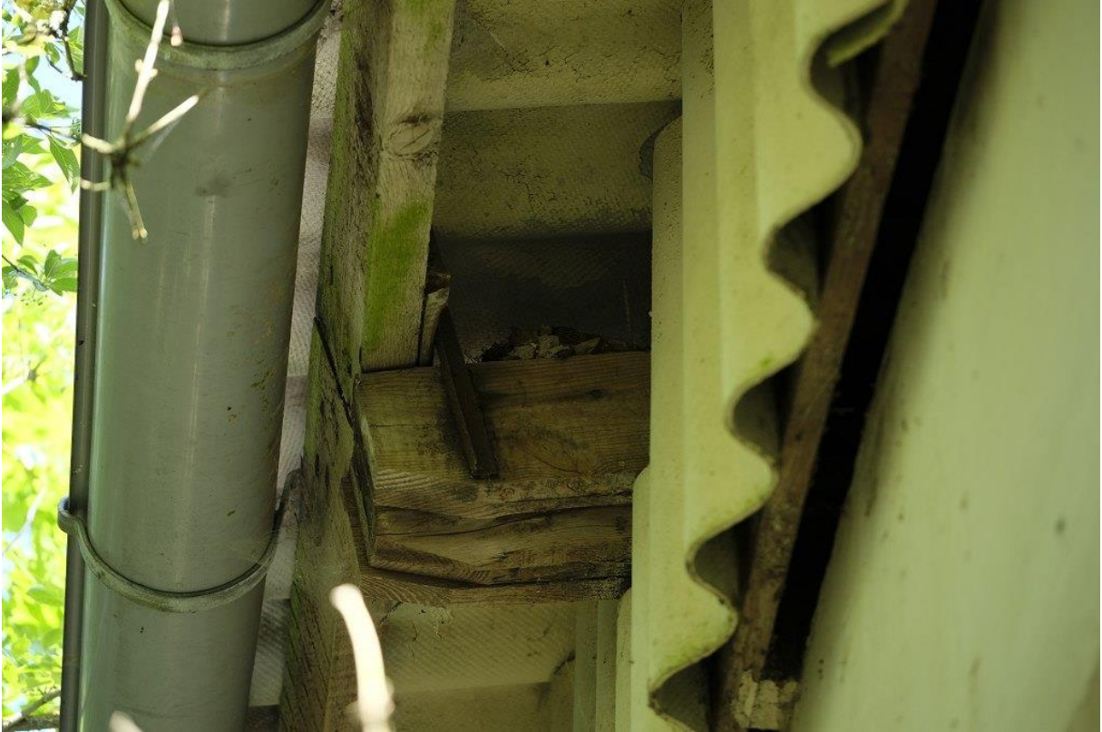
Abbildung 24 altes Nest (Hausrotschwanz?) im Außenbereich von Gebäude Nr.7
