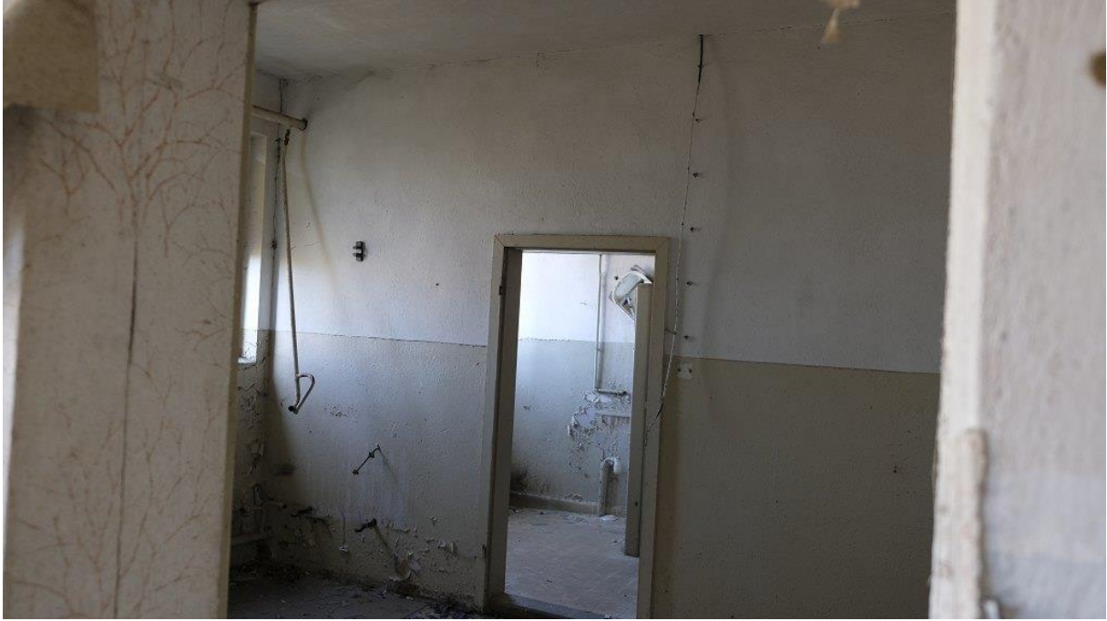
Abbildung 22 Im Bürogebäude (Nr.9)
