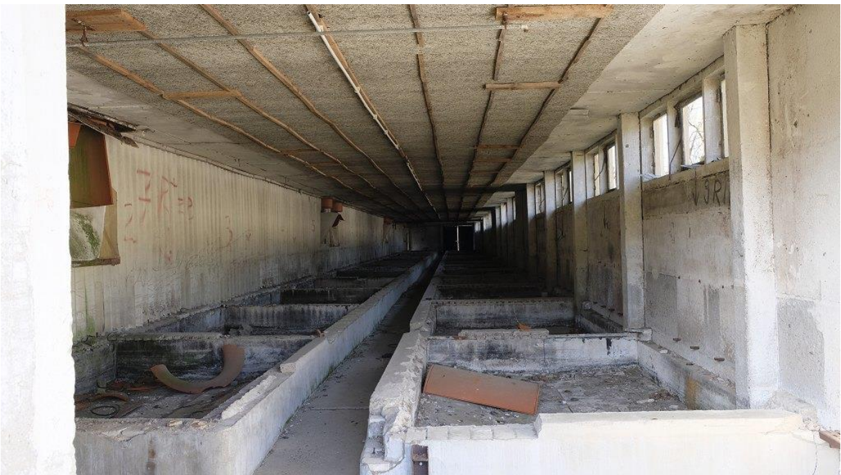
Abbildung 15 Gebäude Nr.5 von Innen
