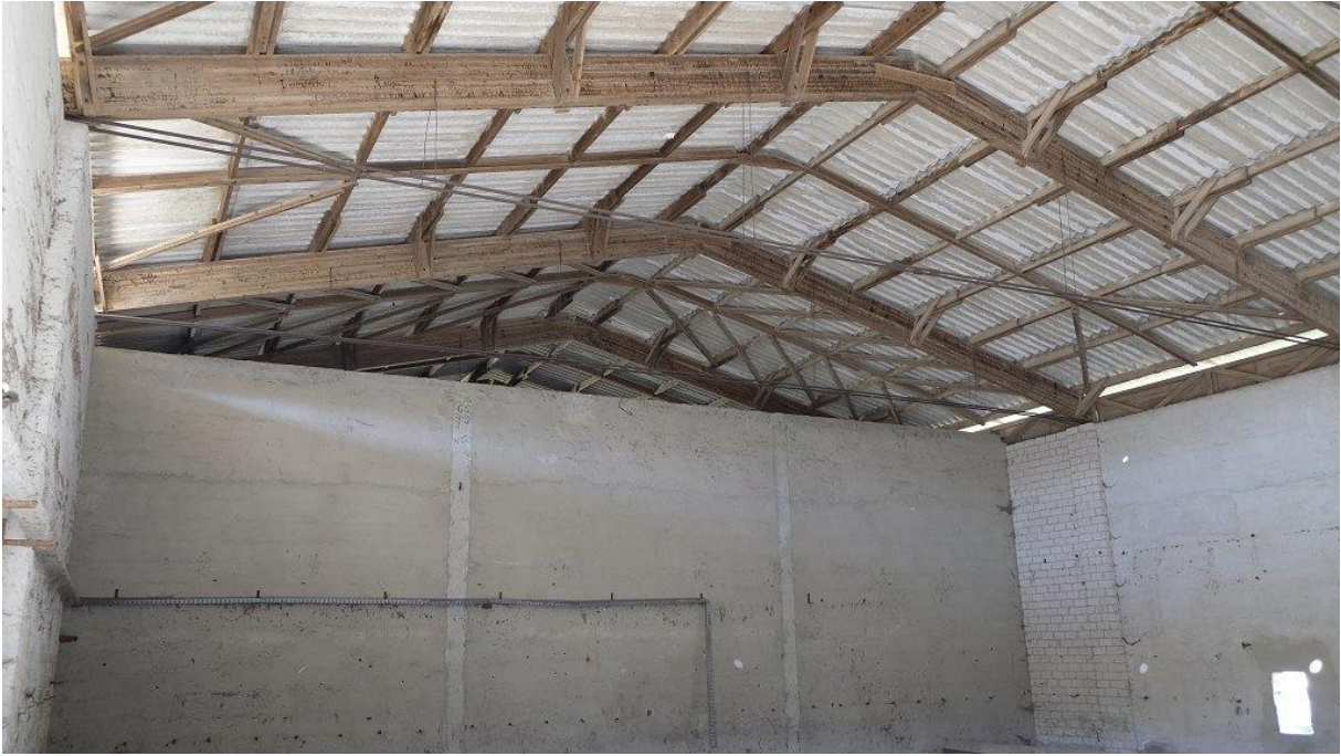
Abbildung 14 Ostteil des Gebäude Nr.6 (hohe Fledermausaktivität im Gebäude)
