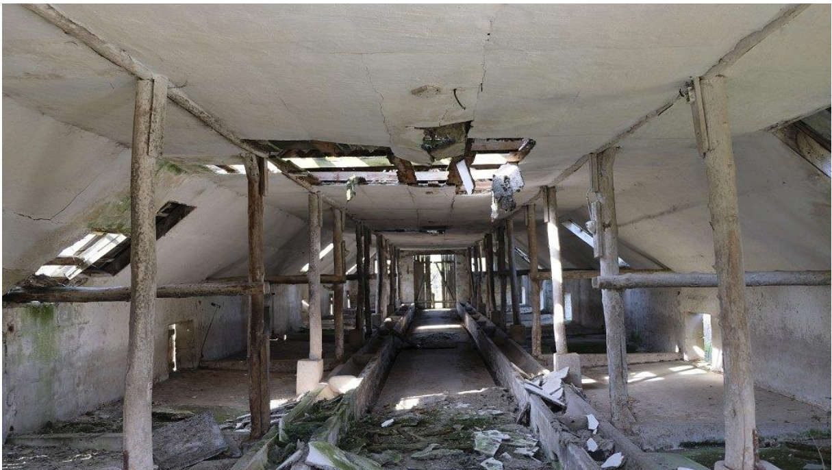
Abbildung 21 Blick in Gebäude Nr.10
