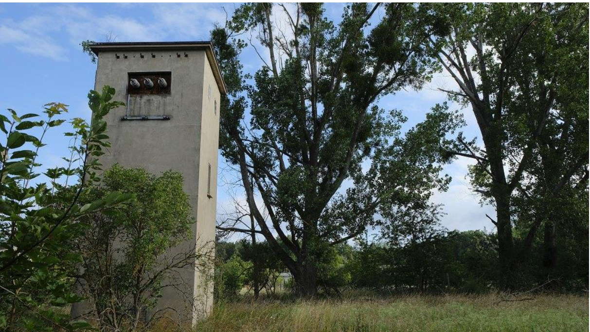
Abbildung 31 Trafoturm südlich außerhalb des Geltungsbereichs Haus Nr.12
