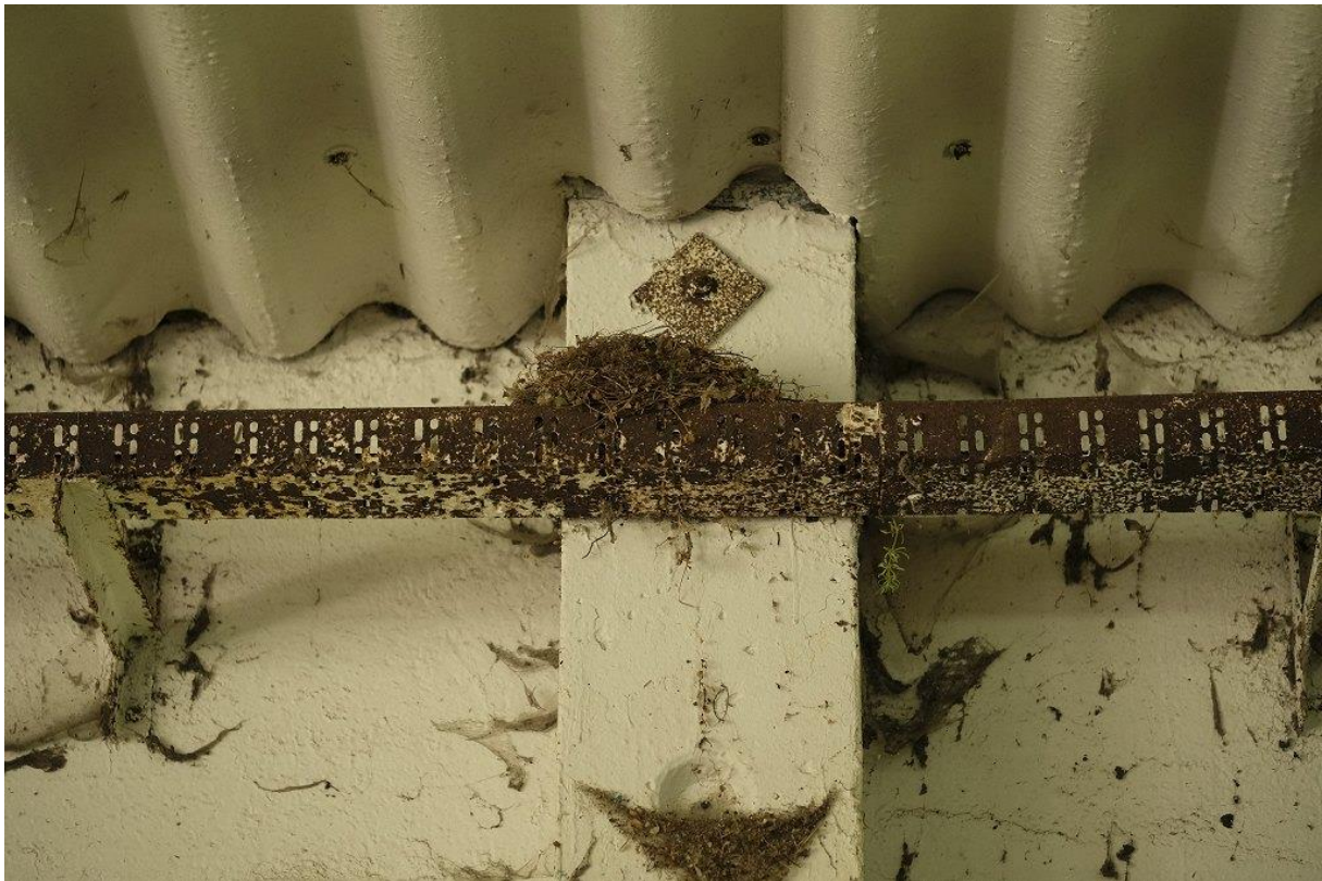
Abbildung 23 Nest vom Hausrotschwanz auf Kabelkanal
